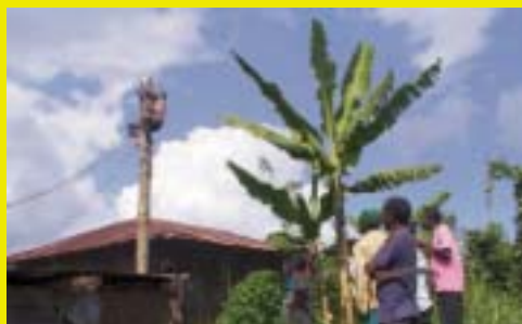
Installation des poteaux électriques à Kathamba.
