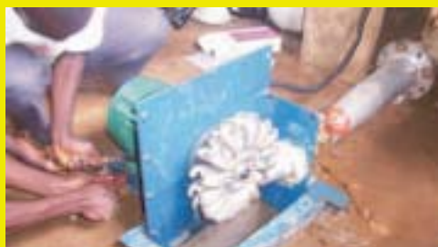
Installation de la turbine (Kathamba).
