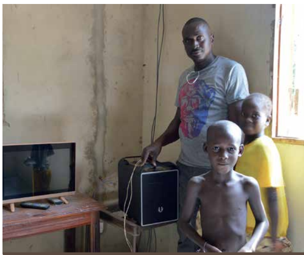
Le module installé par Ingenious Particles permet à ce bénéficiaire de prépayer son service électrique.
