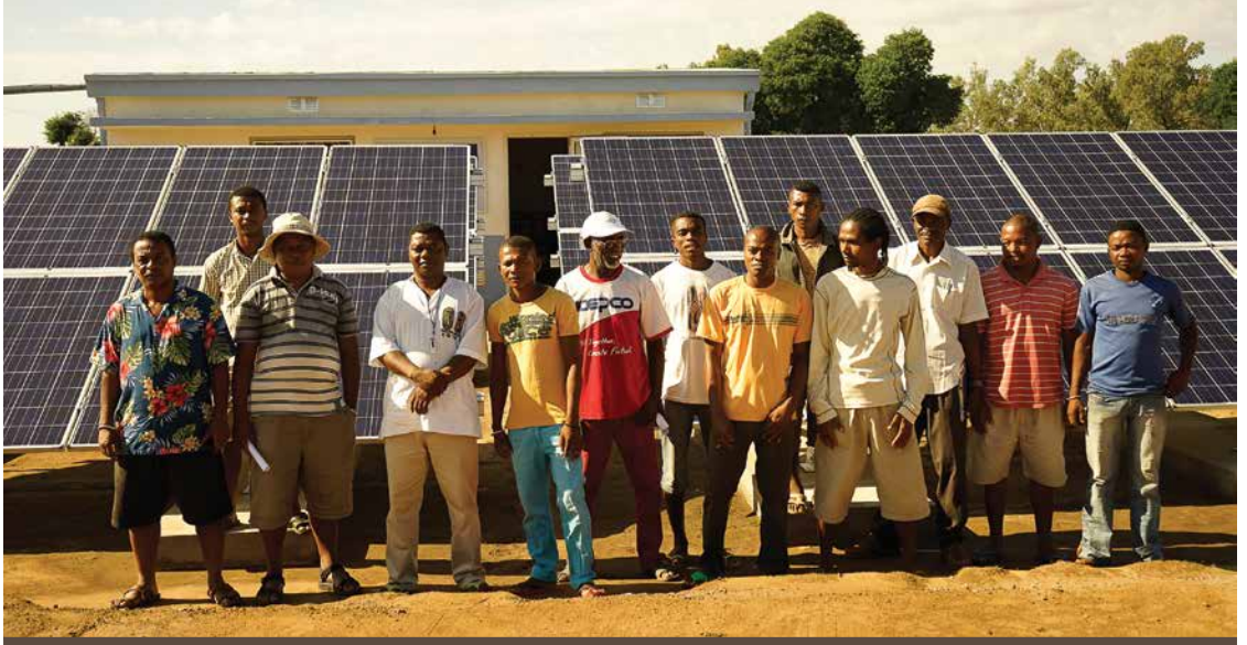
Dans les 7 localités de BOREALE, les centrales solaires fournissent un service continu 24/24 et les exploitants maîtrisent la gestion technique.
